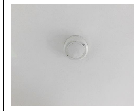
ภาพที่ 2.3-21 เครื่องตรวจจับความร้อน
