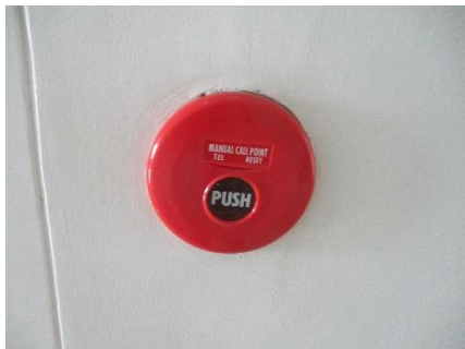
ภาพที่ 2.3-34 อุปกรณ์แจ้งเหตุด้วยมือ
