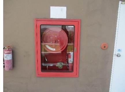
ภาพที่ 2.3-33 ตู้สายฉีดน้ำดับเพลิง
